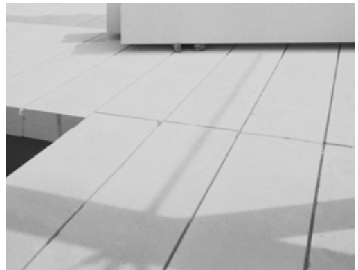
Hebel Deckenplatten auf Stahl-Unterkonstruktion.
