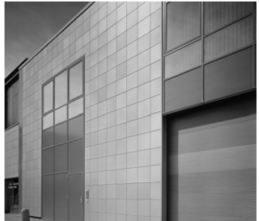
Fassadenelemente aus Composit-Werkstoff auf Porenbeton.
