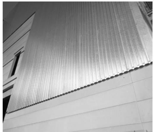
Metallbekleidung auf Porenbeton (Trapezprofilierung).
