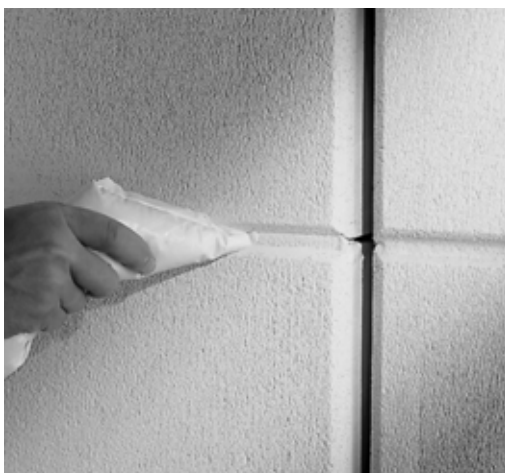
Verfugung der Lagerfuge von Hebel Wandplatten mit Kleber und Fugenfüller.
