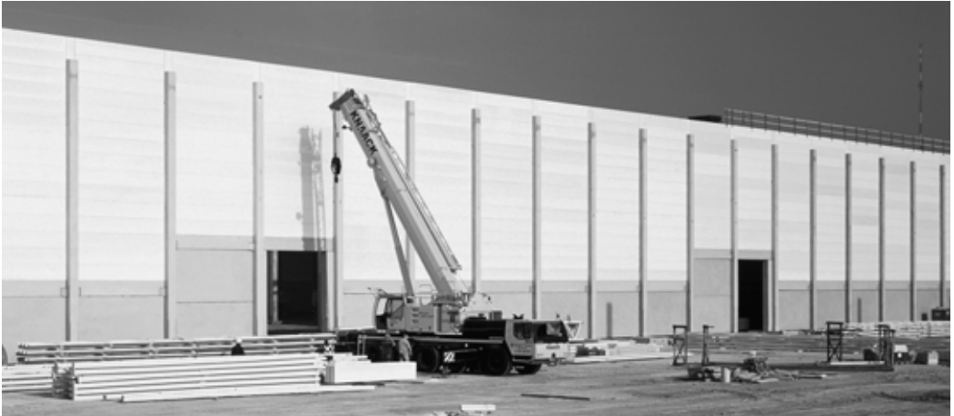
Rationell bauen mit großformatigen, modularen Hebel Montagebauteilen.
