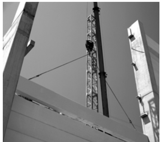
Bis zu 8,30 m lange Hebel Wandplatten für rationellen Montagebau.
