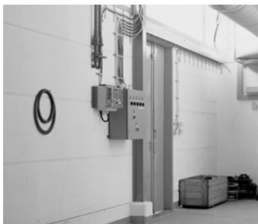
Verschiedene Arten der Befestigung in Hebel Wandplatten.
