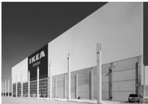
Hebel Komplextrennwände im IKEA Zentrallager Salzgitter.
