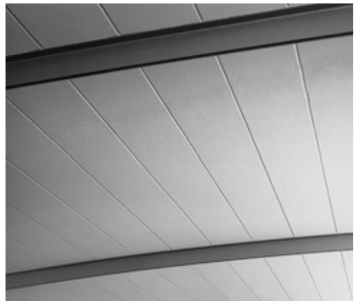
Innenansicht eines Hebel Daches.
