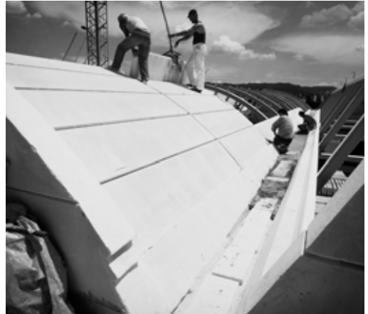
Halbrundes Sheddach aus Hebel Dachplatten.
