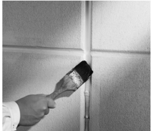
Verfugung der vertikalen Stoßfugen von liegenden Hebel Wandplatten mit plastoelastischer Fugenmasse.
