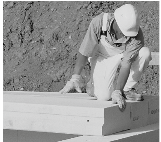
Hebel Dach- und Deckenplatten liegen nahezu fugenlos auf Porenbeton-Wänden.
