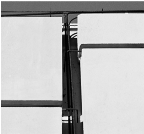
Hebel Deckenplatten mit eingelegter Fugen- und Ringankerbewehrung.
