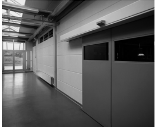
Brandwand aus Hebel Brandwandplatten.
